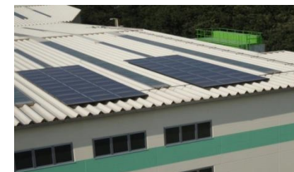
太陽光発電の設置
