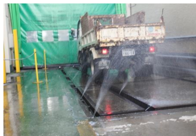
公道を汚さない環境対策 雨水再利用のタイヤ洗浄装置
