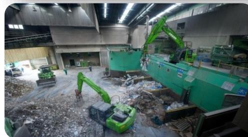
現場CO2排出無 電動型重機の導入
