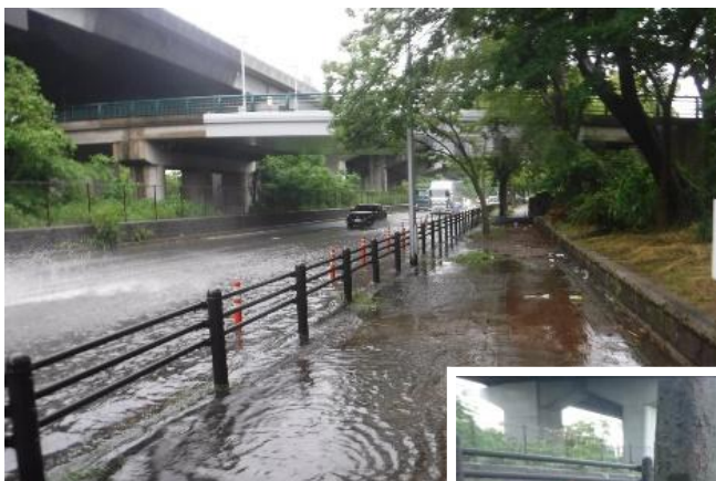
道路の浸水状況 (八尾市内)
