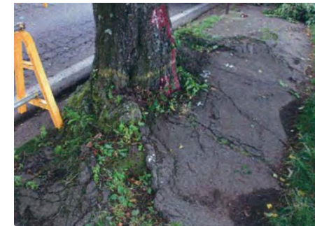
大径木化による根上がり
