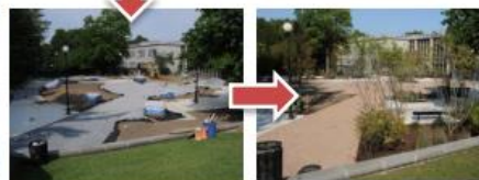
下水道エリア内の私有地を緑化し、雨水管理に貢献することに対して助成金が支払われる
