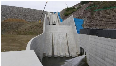
16 安威川ダム放流側
