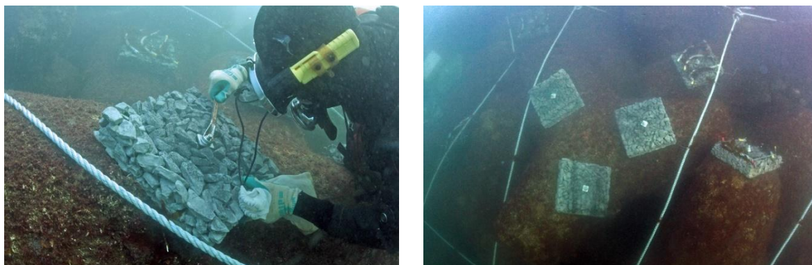
図Ⅱ-1-25 基質取付状況(左)、基質設置完了全景(右)
