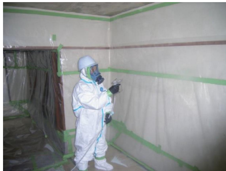
図 4.7.79 隔離シートへの粉じん飛散防止処理剤の散布
