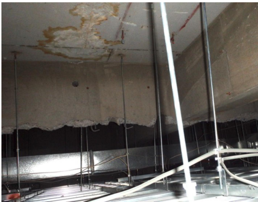
最上階の天井裏の断熱材
