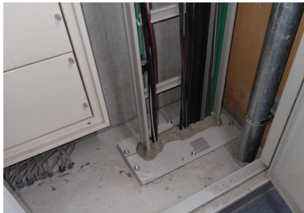
区画貫通部の防火措置
