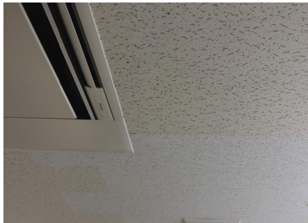
石膏ボード+ ロックウール吸音天井板（1964～1987）
