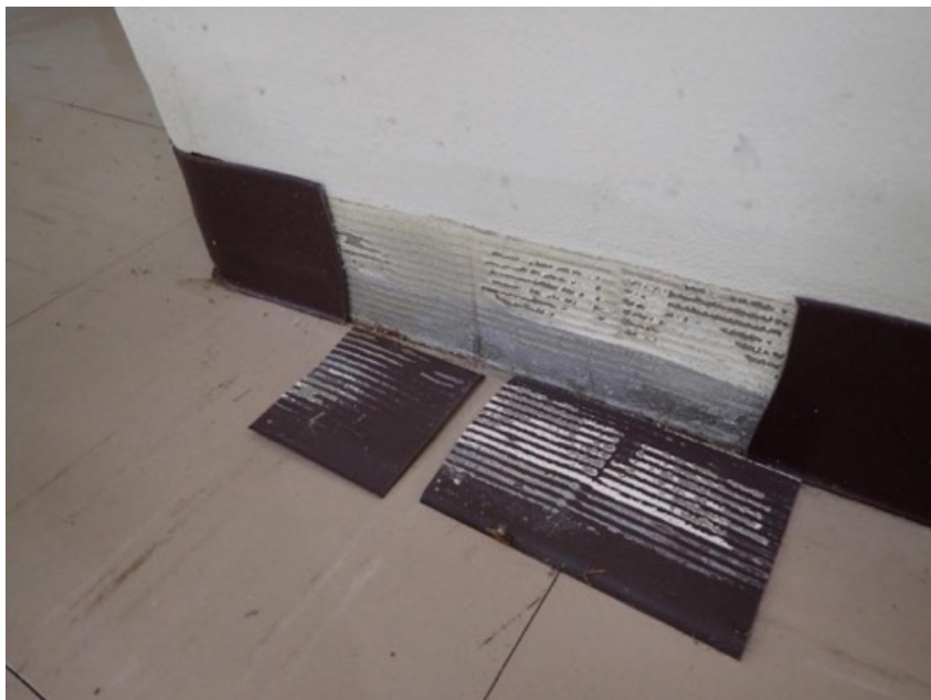
巾木（壁のクロスと接着材も除去）
