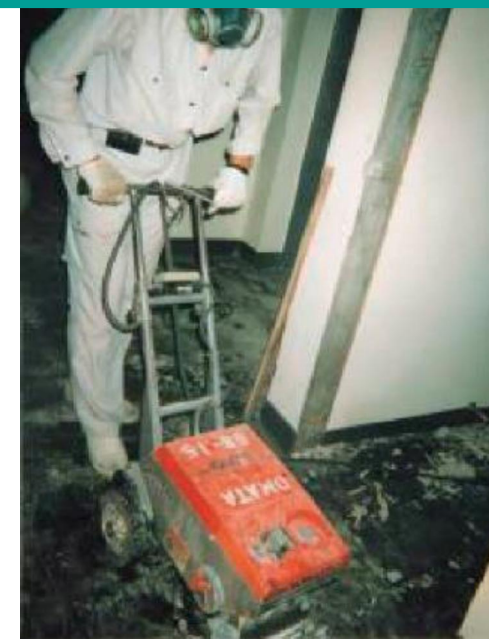
図4.11.12 石綿含有ビニル床タイルの 除去例
