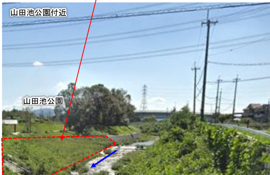
緩傾斜護岸を整備し、植生を復元
