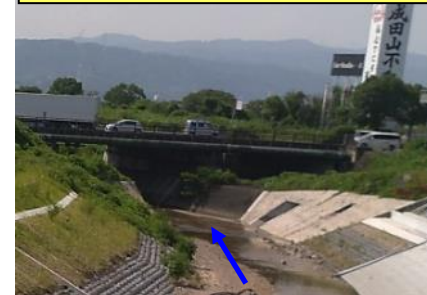
改修後(穂谷川新橋付近)
