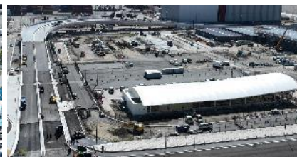
(仮称)夢洲南高架橋舗装工事中 (2024年10月)
