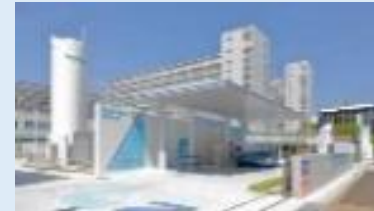
充電設備・水素ステーション整備
