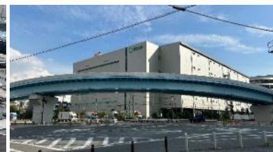
(仮称)舞洲東高架橋桁舗装工事中 (2024年10月)
