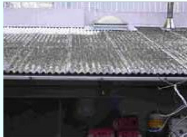
波型スレートの拡大写真
