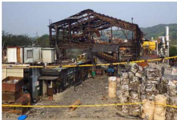
上記、アルミ鋳造工場で浸水により水蒸気爆発した状況の写真 ※1
