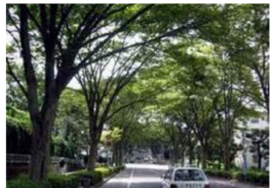
沿道地域との協働による街路樹の再生
