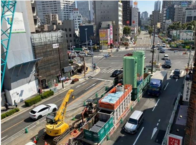
地中連続壁工（JR福島駅付近）
