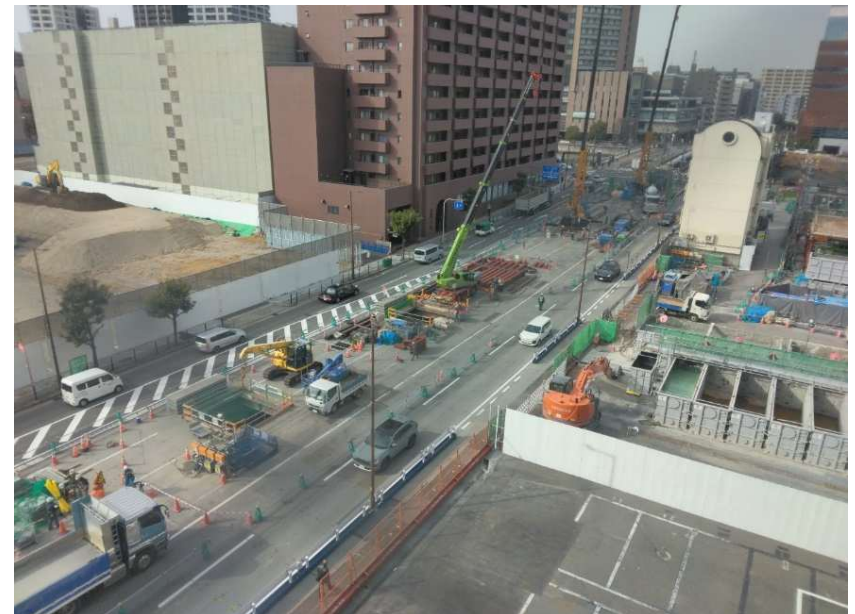
掘削工（中之島駅）
