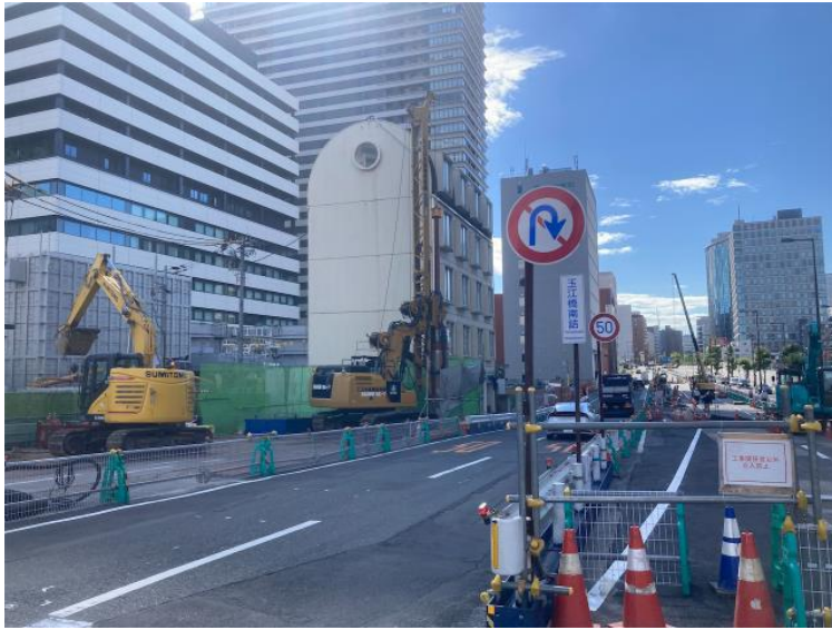
土留工（中之島駅）
