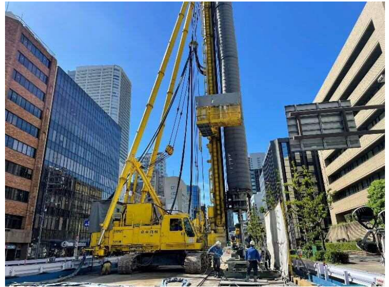
土留工（西本町駅）
