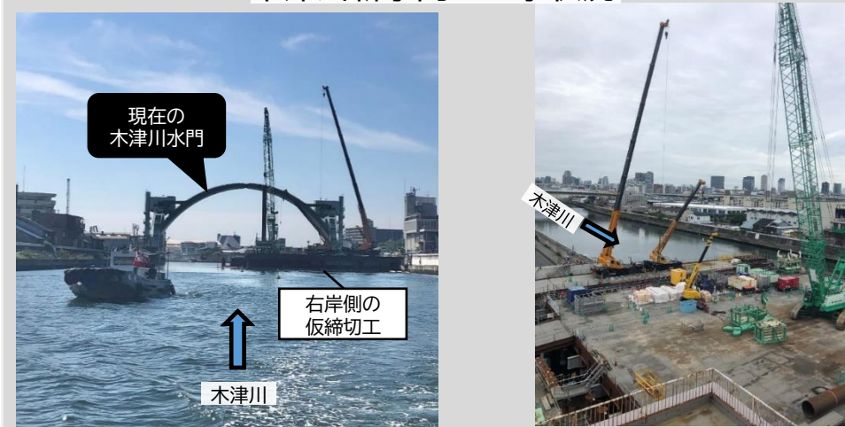
木津川新水門の工事状況
