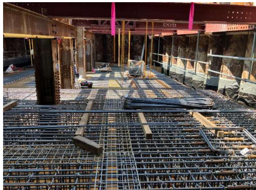
トンネル本体工（道頓堀川付近）
