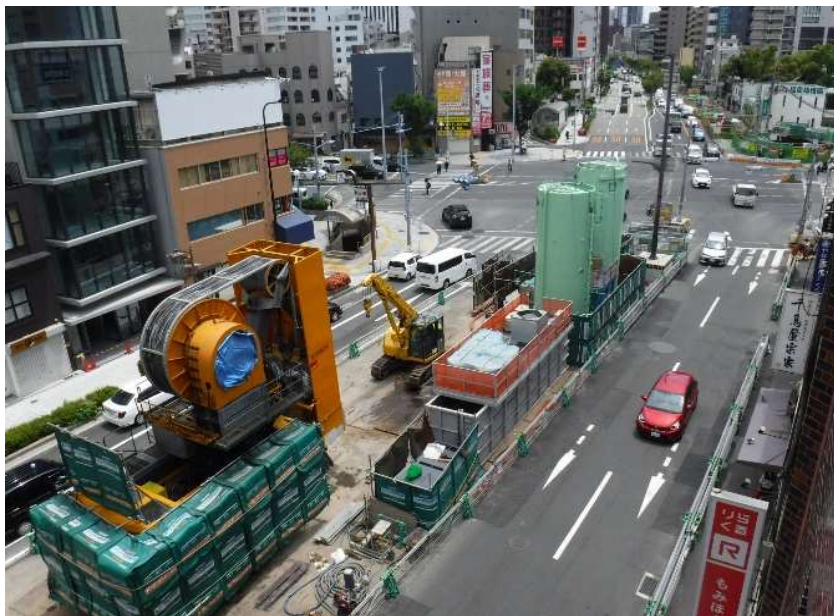
地中連続壁工（JR福島駅付近）
