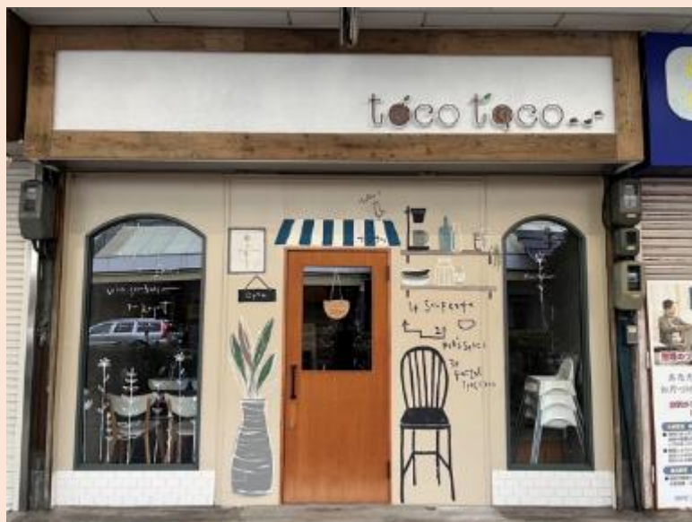
空き店舗を改修した、 カフェ・キッズスペース・レンタルスペースの 複合施設「Tocotoco..」
