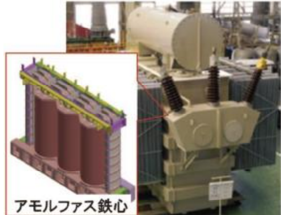
大容量アモルファス変圧器(試作器)
