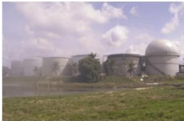
FELDA社工場稼働中の排水処理タンク
