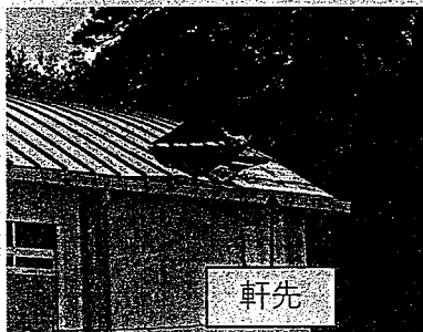
台風による軒先からの金属屋根剥がれ
