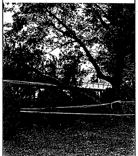
暴風による倒木で、学校施設が破損。
