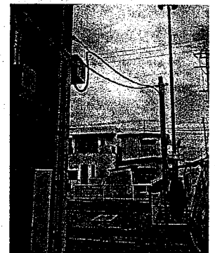
高圧受変電設備が利用できないため、校外の電線より低圧電力を引き込み、仮設電源として利用
