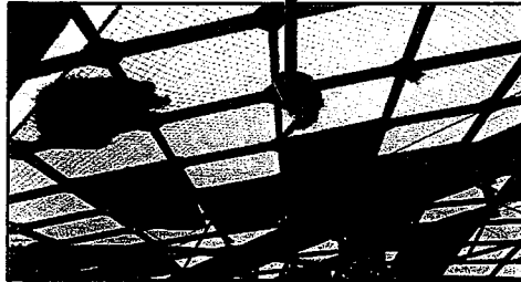
下地材も多数飛散したが、落下防止ネットが設置されていたため、部材の落下を防ぐことができた。
