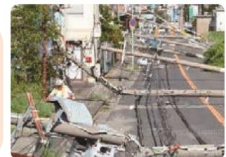
台風21号による強風でたおれた電柱 (2018年9月5日・大阪府泉南市)
