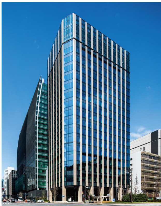
日鉄日本橋ビル
