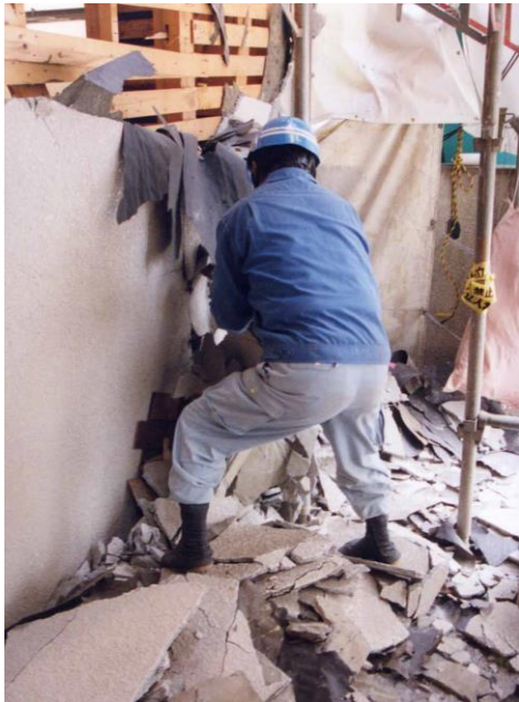
外装材の取り壊し
