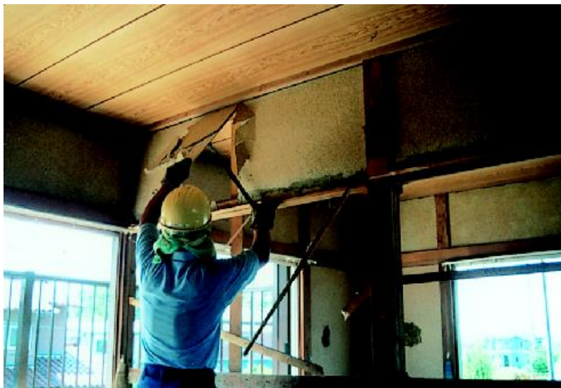
内装材の取り外し
