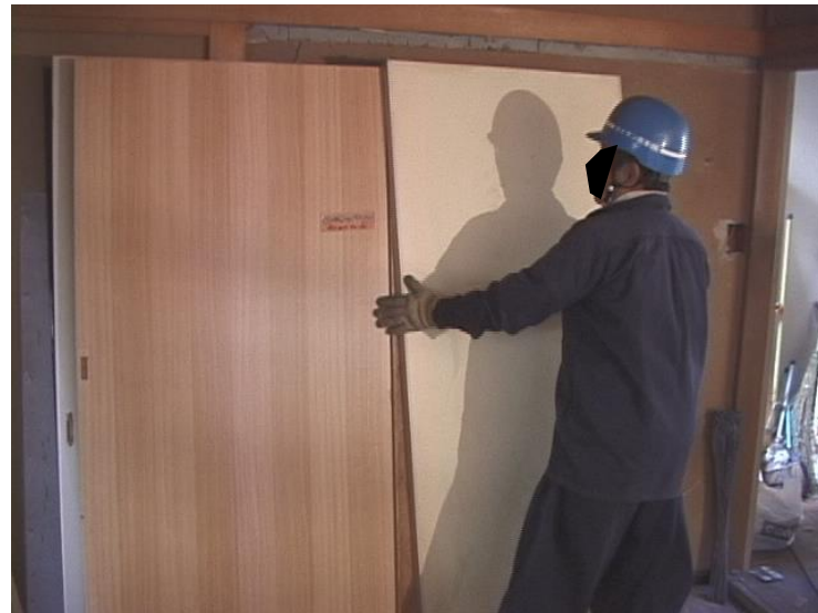
建具の取り外し
