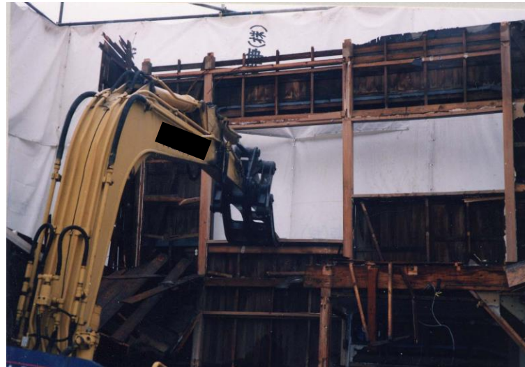
上部構造部分の取り壊し
