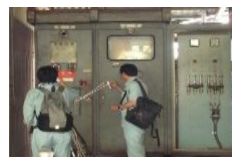
PCB廃棄物に係る立入検査
