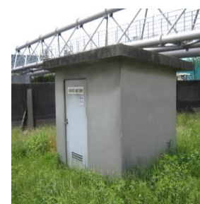
地盤沈下・地下水位観測所
