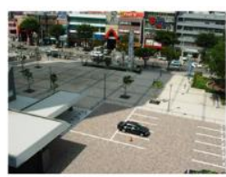
透水性・保水性舗装
