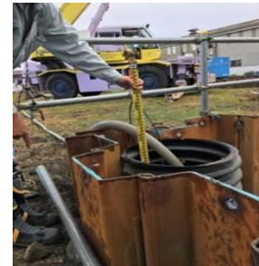
汚染土壌掘削工事の現地確認状況(地下水位の確認)
