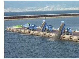
フェニックス処分場での 廃棄物受入
