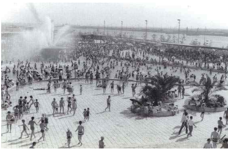
変形大プール 昭和39年（1964年）
