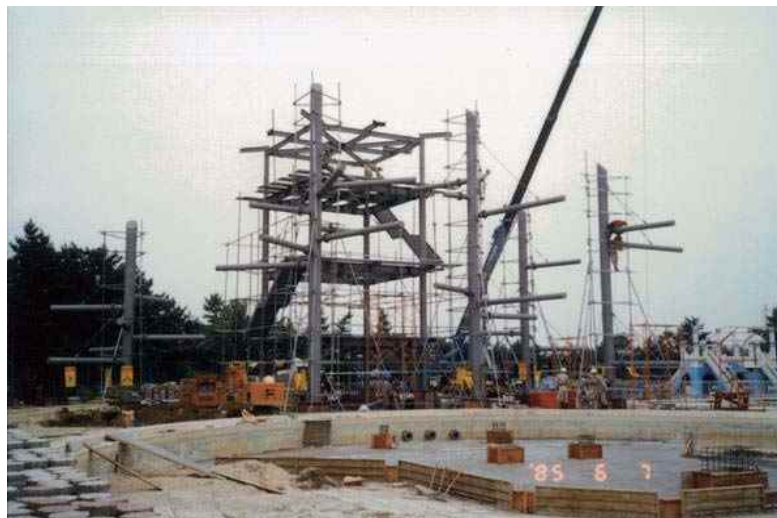
ジャイアントスライダー建設中 昭和60年（1985年）
