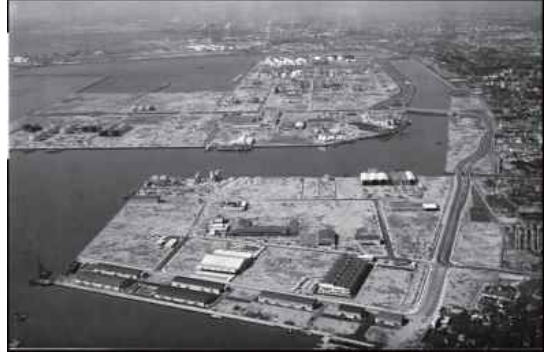
浜寺水路 航空写真
