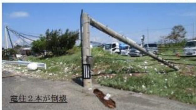
●泉大津沖埋立処分場 【平成30年9月5日(水) 撮影】
