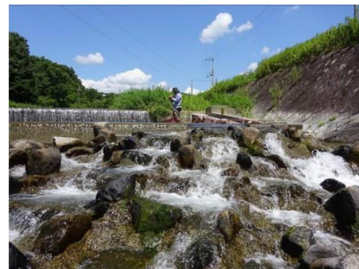
川島井堰 石の魚みちでの遡上調査
