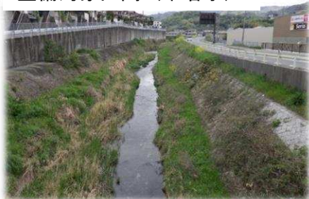
整備対象区間 (未着手)
