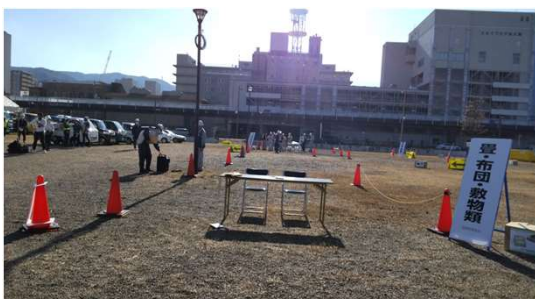
②仮置場設置
