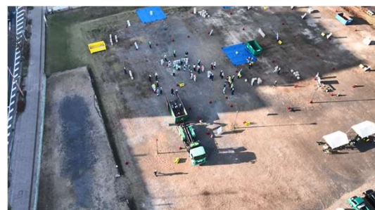
④仮置場からの搬出
