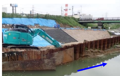
鋼矢板による仮設水路設置状況(穂谷川新橋上流)
