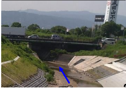
改修後(穂谷川新橋付近)
