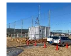
ボーリング調査の様子 (奈良県内)
