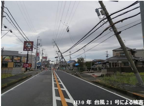
【電柱倒壊等による道路閉塞】
