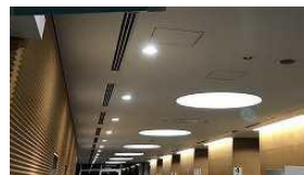
区役所フロアのLED照明
