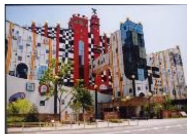
実証フィールド： 大阪広域環境施設組合舞洲工場
