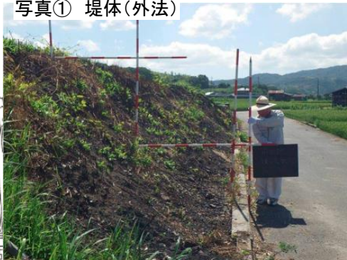
写真① 堤体(外法)
