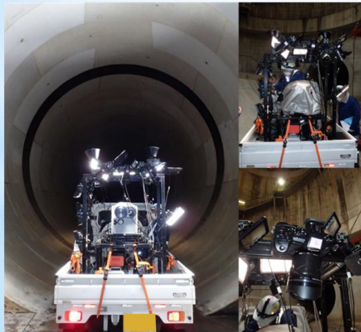
走行型画像計測の実施事例（若江調節池）
