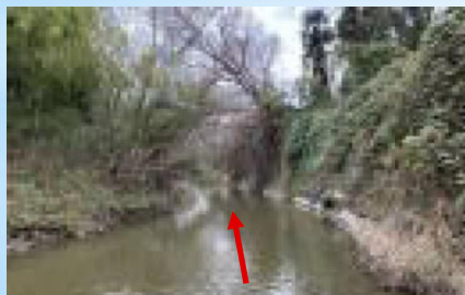
近接目視困難箇所の事例(東除川)
