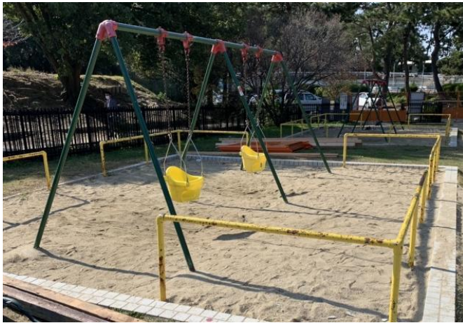
当初の改修予定：R9年度 健全度：C
