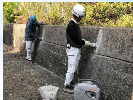
ひび割れ補修(部分)
