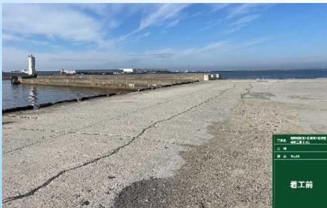
路盤+コンクリート舗装の更新(全面)
