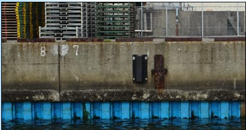
ペトロラタム被覆による鋼矢板の防食(全面)
