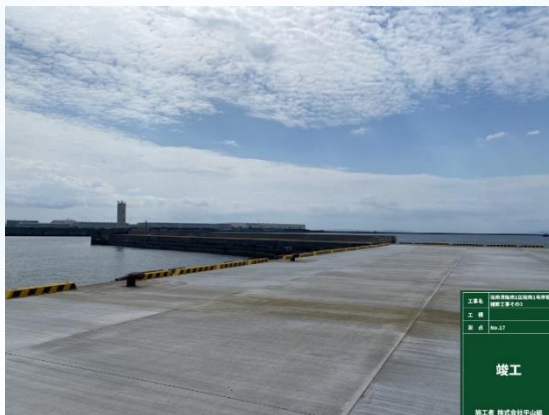
路盤+コンクリート舗装の更新(全面)
