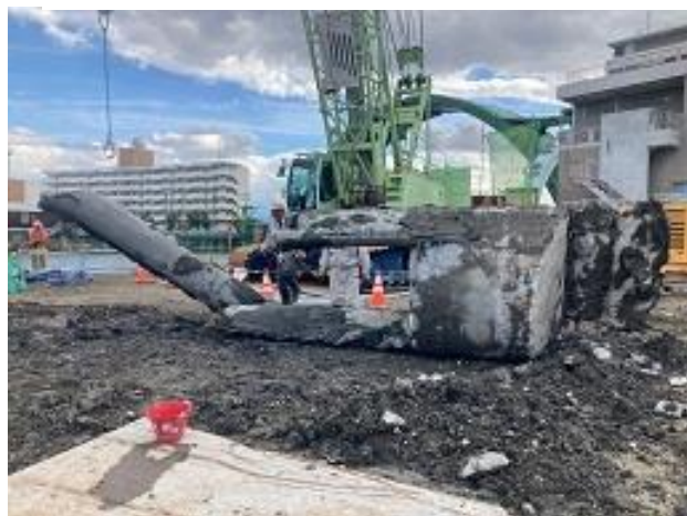
(参考)木津川水門の撤去工の状況
