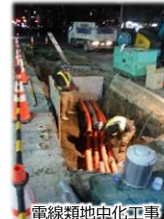
電線類地中化工事
