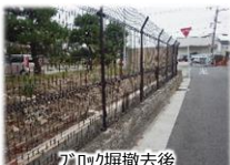
ブロック塀撤去後
