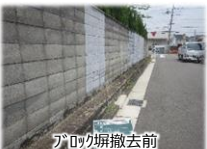
ブロック塀撤去前
