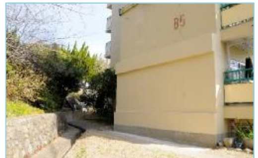
耐震壁補強（新千里北住宅）
