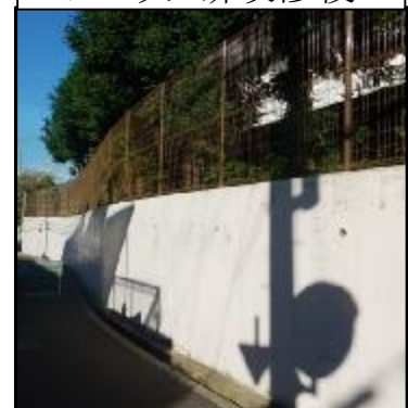
ブロック塀改修後
