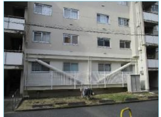
耐震壁補強（新千里北住宅）
