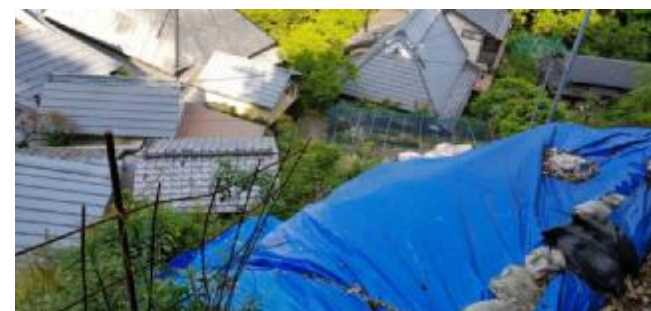
保全対象：府道（避難路）及び人家
