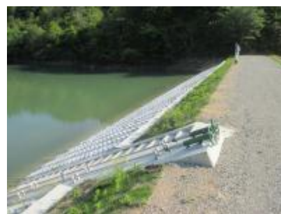
ため池の改修（阪南市） （上：改修前／下：改修後）
