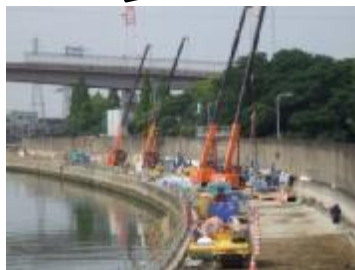
防潮堤の対策 (神崎川 (城島橋下流右岸)) 左: 施行中 / 右: 施工後
