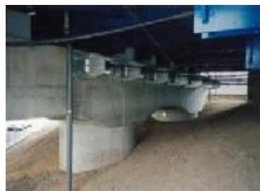
橋梁耐震化 対策後
