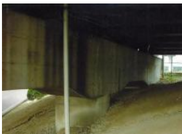
橋梁耐震化 対策前
