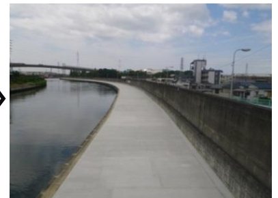
防潮堤の対策 (神崎川 (城島橋下流右岸)) 左: 施工中 / 右: 施工後
