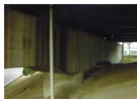
橋梁耐震化 対策前
