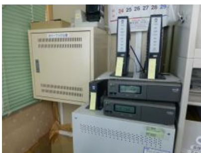
平成30年台風第21号による停電の際、EVから電話のデジタル交換機へ給電
