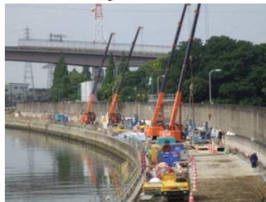
防潮堤の対策 (神崎川 (城島橋下流右岸)) 左: 施工中 / 右: 施工後
