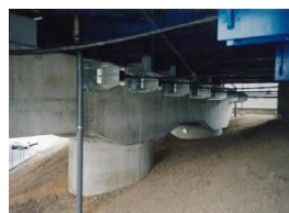
橋梁耐震化 対策後
