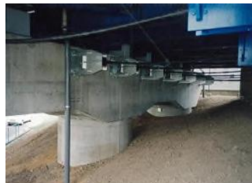
橋梁耐震化 対策後
