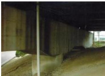
橋梁耐震化 対策前
