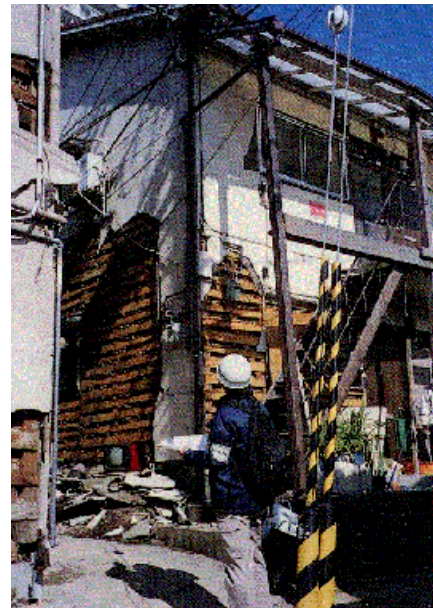
応急危険度判定の様子 (全国被災建築物 応急危険度判定協議会HPより)
