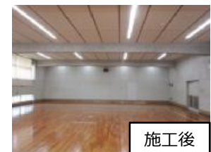
非構造部材の耐震化 (門真西高校剣道場)
