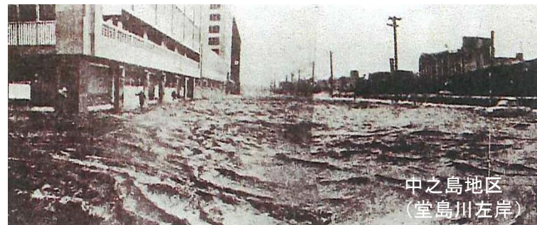
第二室戸台風の高潮による被害状況写真
