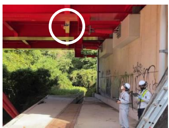
ドローンを活用した橋梁点検
