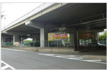
国道 423号 江坂高架橋下（吹田市） 9
