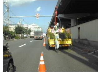
道路施設の清掃
