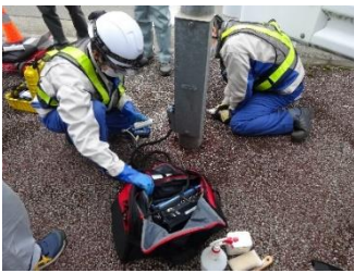
照明柱の非破壊調査
