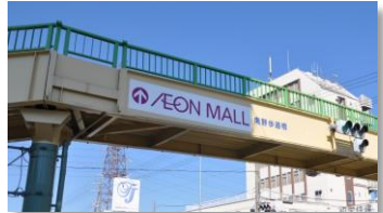
国道 170号 南野歩道橋（四條畷市）
