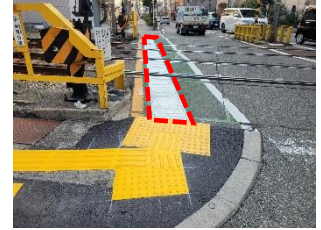
踏切内の誘導用ブロックの設置 （箕面市）
