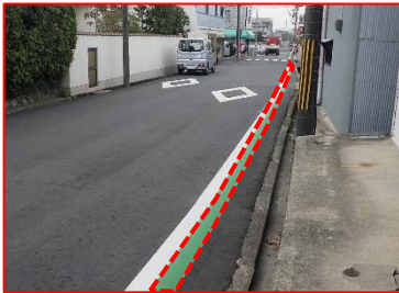
路肩のカラー化（熊取町）
