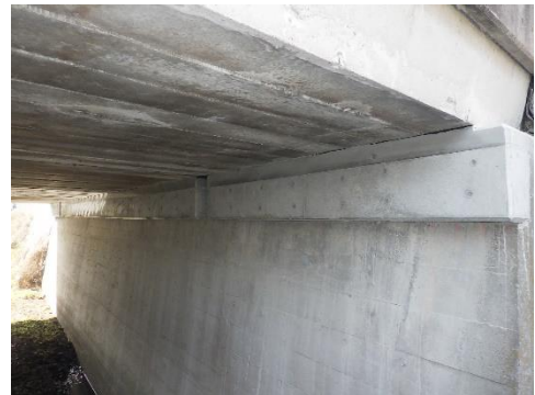
落橋防止対策 (府道 大阪中央環状線・茨木市)
