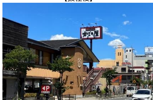
【無電柱化の事例】 国道 176号（豊中市）
