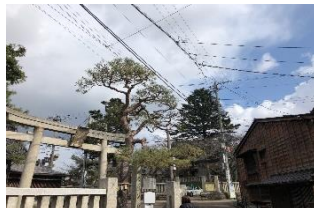
電線による景観阻害
