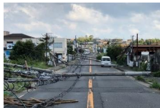
倒壊による道路閉鎖
