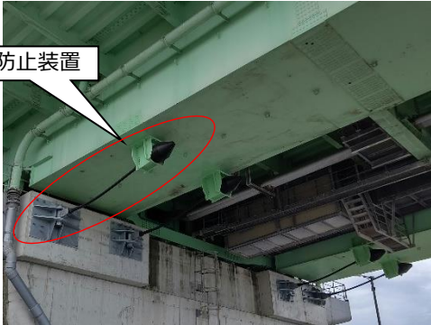
落橋防止装置の設置 (府道 泉佐野岩出線・泉南市)
