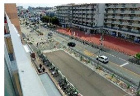
〔道路の整備（4車線化）〕
