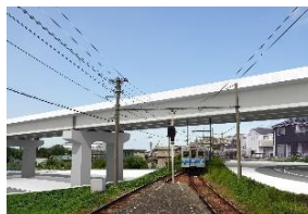
〔道路と鉄道の立体交差〕
