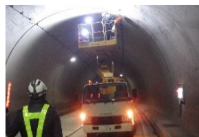
〔トンネル点検〕
