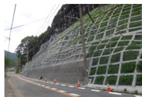
〔道路法面对策〕
