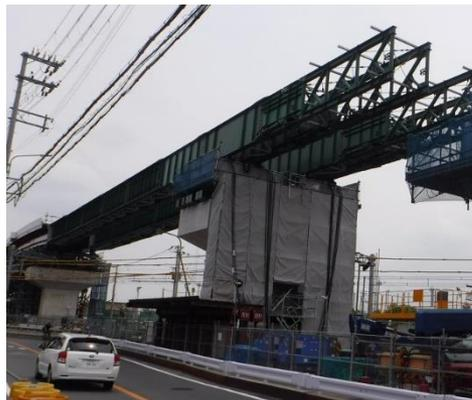
・桁架設箇所にベント（仮受け構台）を設置、桁架設箇所の付近にクレーンを配置し、クレーンで桁を吊り上げて架設する工法
