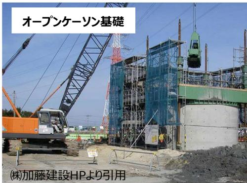
・筒状の構造物を沈設し、掘削を繰り返しながら、既定の深さまで到達後に、コンクリートを打設し、基礎を構築する工法
