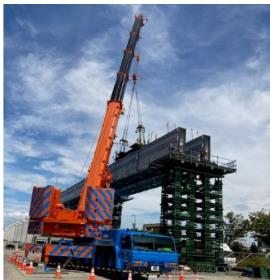
当初：クレーンベント架設
